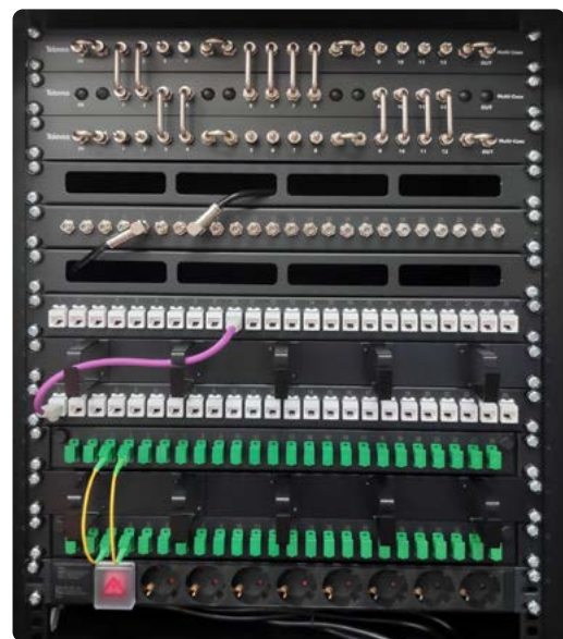
▲ ATE ou PDS em Bastidor 19"
